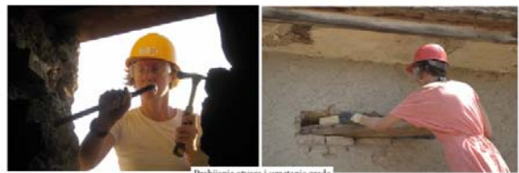
Probiranje otvora i umetanje grede
