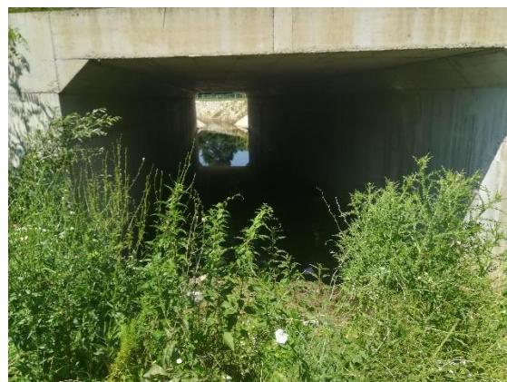
Слика 20. Насип у зони ушћа Суваје (поглед са аутопута) и пропуст испод насипа аутопута
