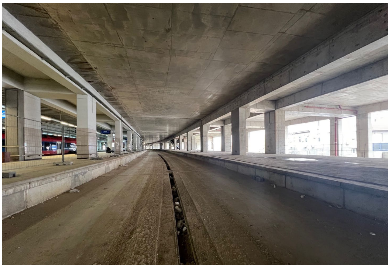
Слика 4: Испод приземља станице Прокоп - перон на коме ће се изводити завршни радови и железничка пруга на којој ће бити постављене нове шине у оквиру пројекта.
