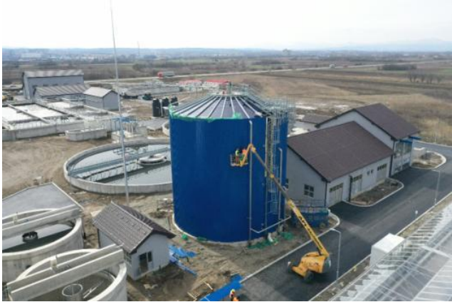
Постављање термоизолације на Објекту 9 (Анаеробни дигестор) и Станица за дозирање FeCl_3
