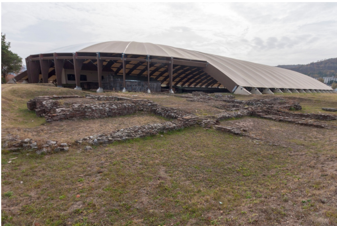
Сл. 8. Простор северно од Виле - поглед на делове заштитне конструкције који се затварају.
