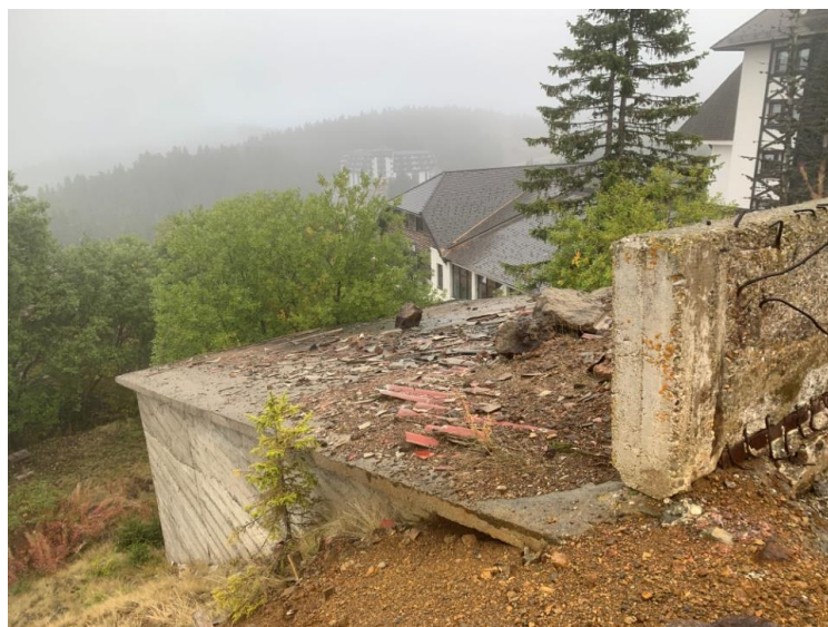
слика 3 Постојећи бетонски излаз из јаме рудника
