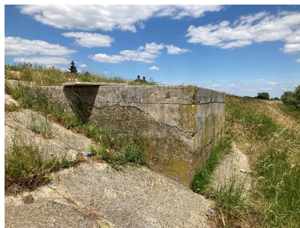
Слика 5-7. Ревизиони шахт потисног цевовода
