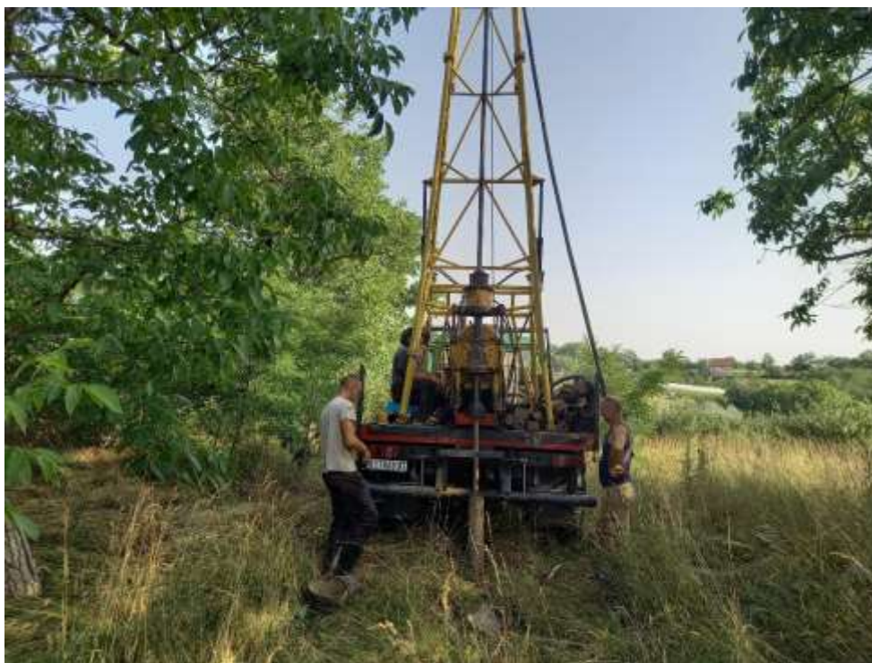
Слика 4: Истражно бушење за потребе трасе пута
