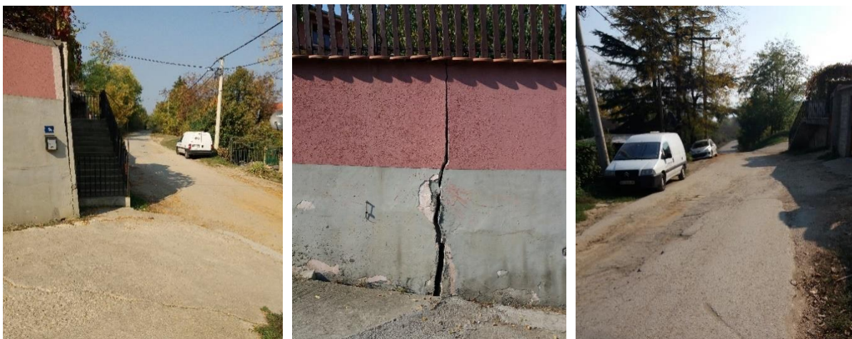
Слика 6: Оштећења на објектима у зони клизишта BG 17.2.7b
