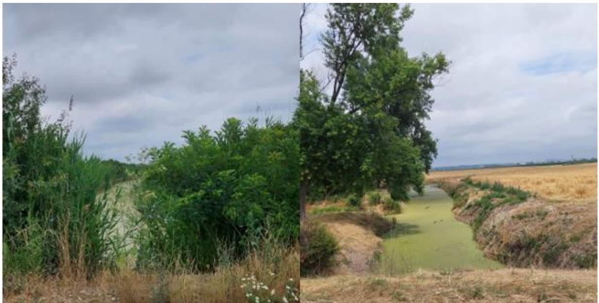
Слика 10: мелирациони канали обрасли самониклом вегетацијом
